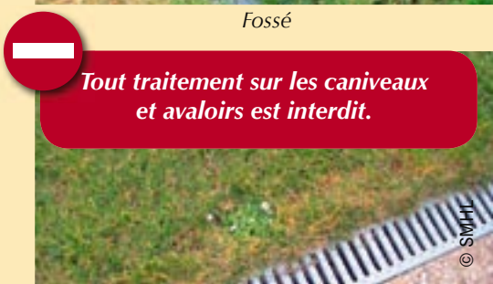
Avaloir d'eau pluviale
