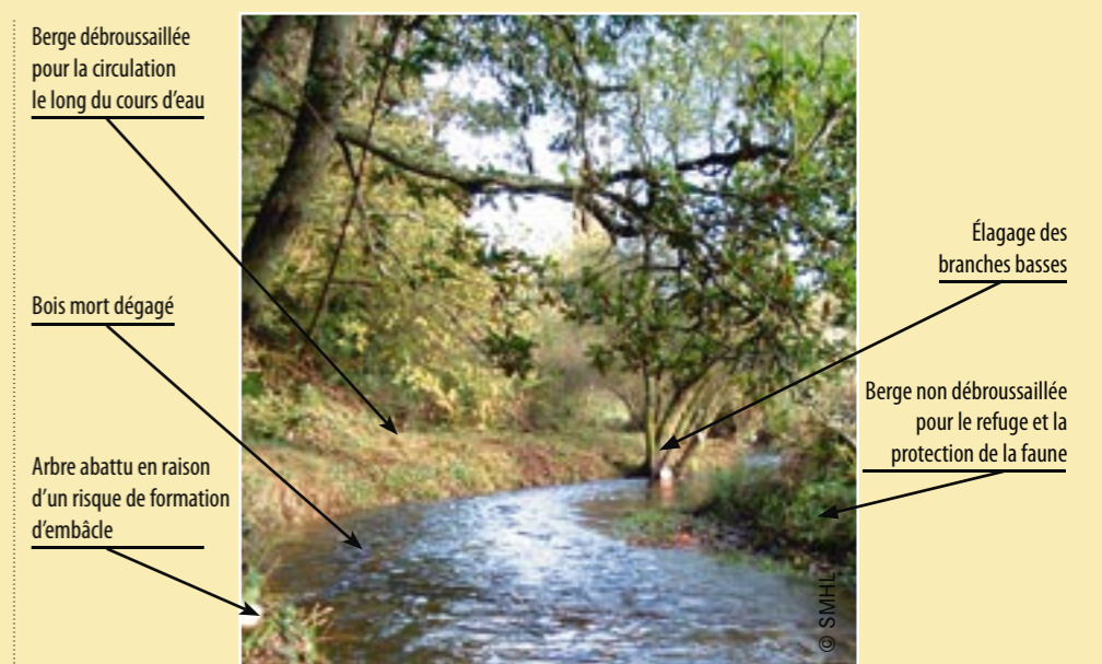
Coatoulzac'h/aval du Moulin de Mintric après travaux
